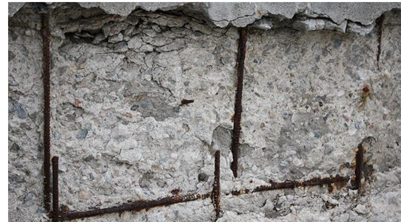
Spalling
